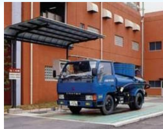
トラックスケール
