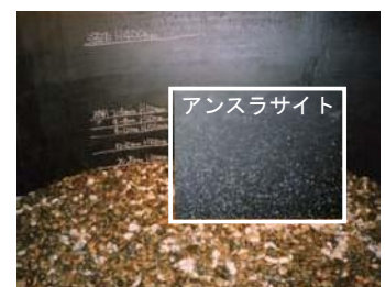
二層ろ過器内部
